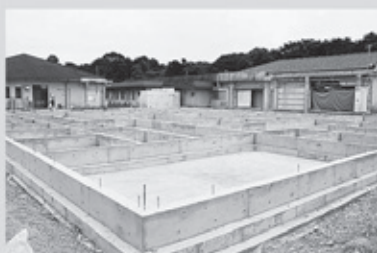
基礎工事 10月3日
