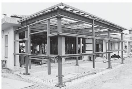
厨房増築部分
