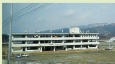
手付かずのままの、3階まで被害のあった建物
