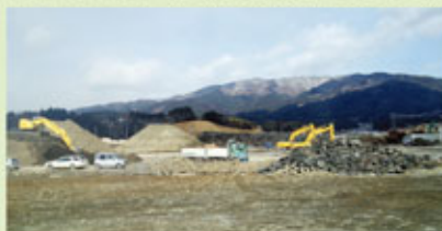
未だ造成中の被災地
